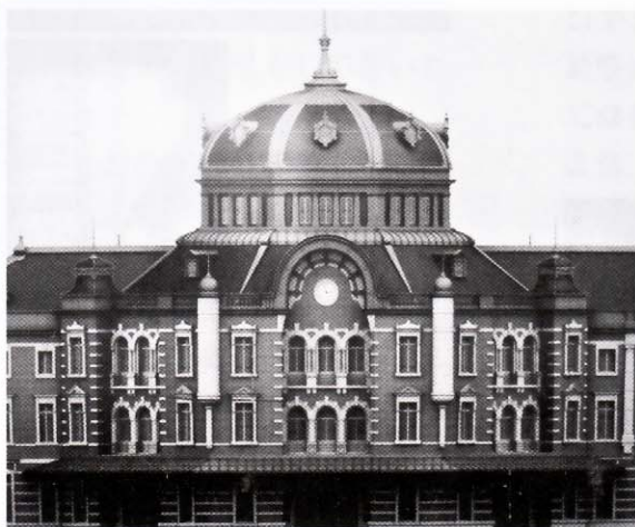
(東京駅銅板工事施工)
